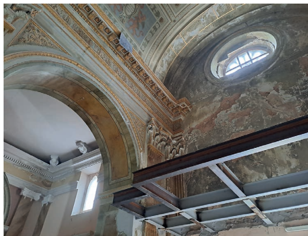
Santuario Madonna del Cerro, Sassoferrato - interno, particolare della controfacciata (barre in ferro per sostegno cantoria)
